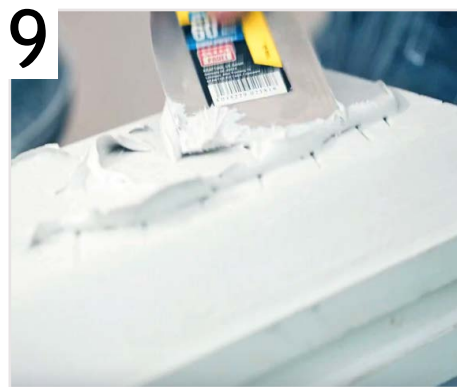
9 Нанесите раствор на тыльную сторону карниза зубчатым шпателем
