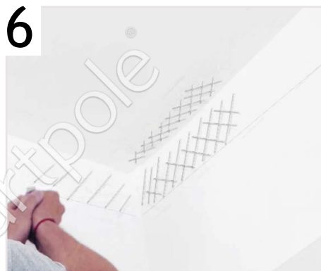
6 Сделайте насечки канцелярским ножом на стене и потолке в месте монтажа карниза
