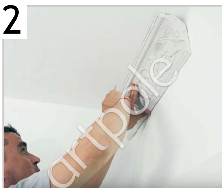
2 Возьмите первую деталь, приложите ее к месту крепления и сделайте разметку на потолке и стене
